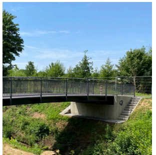
Die neue Brücke auf Höhe des künftigen Begegnungszentrums wurde von DOSER KEMPEN KRAUSE Ingenieure geplant
