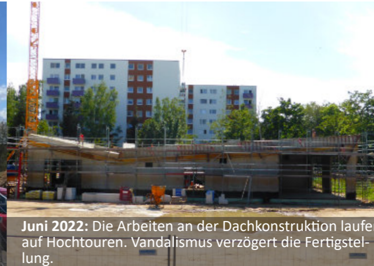
11. April 2022: Die Dämmung unterhalb der Bodenplatte ist verlegt. Es folgt das Herstellen der Bodenplatte durch Einschalen, Bewehren und Betonieren.
